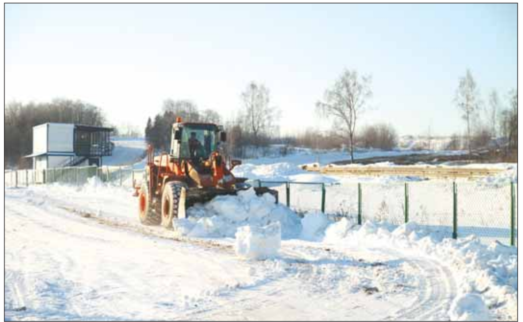
На гоночной трассе завершаются подготовительные работы
