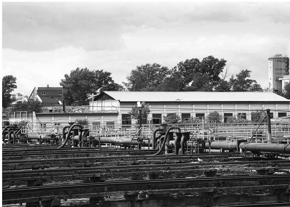
Вода, пройдя механические этапы очистки, подвергается тщательной обработке в специальных резервуарах – аэротенках, где осуществляется глубокая очистка от азотных и фосфорных соединений.
