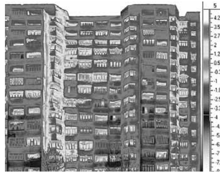
Так выглядит стандартный дом на экране тепловизора.
