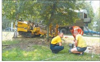
Тишину парка, что за центром досуга «Мир», несколько дней нарушал шум работающей техники здесь компания ООО «ЗЕВСтехнологии», субподрядчик МУП «Истринский водоканал», при помощи спецоборудования прокладывала водопровод бестраншейным способом.
