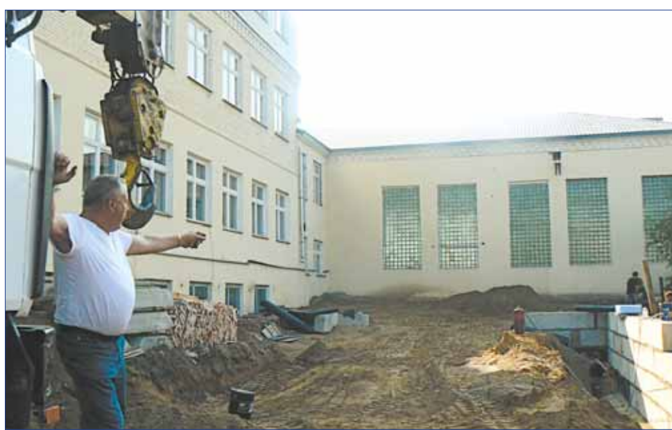
Возведение пристройки к столовой в Чеховской школе идёт полным ходом
