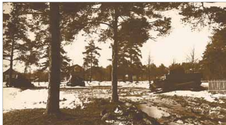
Первые три танка установлены
