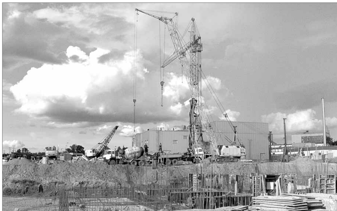
Облака над стройкой... – Красиво. Но через 2 часа – сильнейший дождь...
