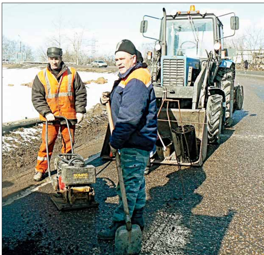
Ямочный ремонт на Волоколамском шоссе
