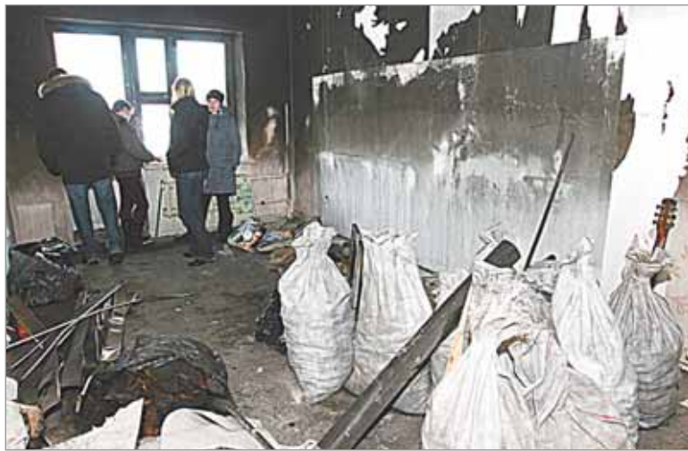
В квартире и подъезде сейчас проводится ремонт
