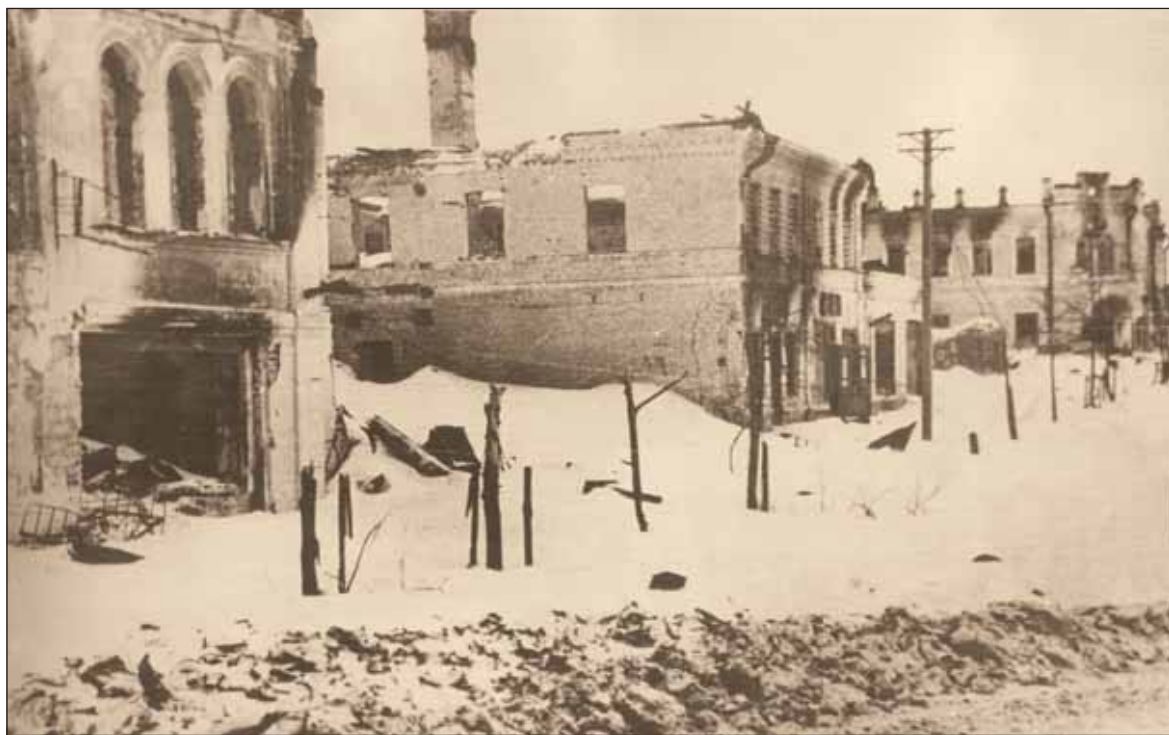
Разрушенная Истра, декабрь 1941 г. (из архива С.И.Кузьмина)
