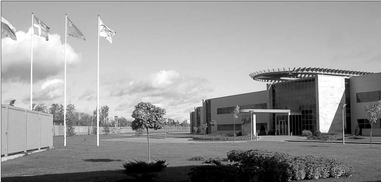
Работы по генподряду завершены. Производственное предприятие Данфосс сдано в эксплуатацию
