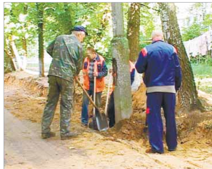
Работы выполняет Истринское ДРСУ
