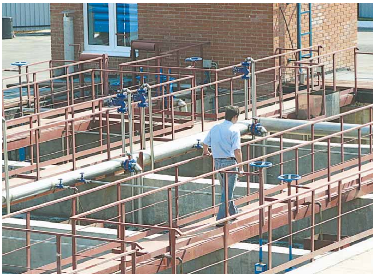
Мощность очистных сооружений в Котово увеличилась в несколько раз
