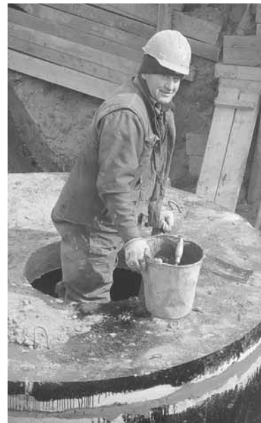
Трубоукладчик В. Валькер
