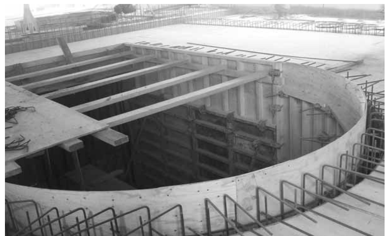
Опалубка, изготовленная бригадой Теплякова
