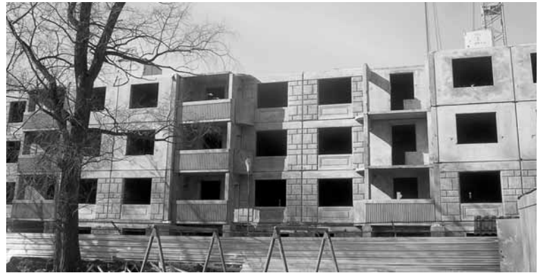
Растут этажи на доме в Снегирях!
