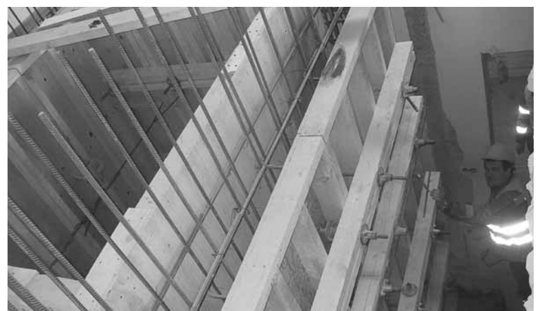
Опалубка, изготовленная бригадой Гудкова
